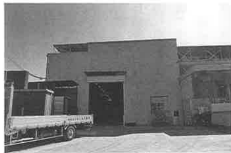
増築した工場建屋
