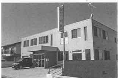
事務所棟を新設
